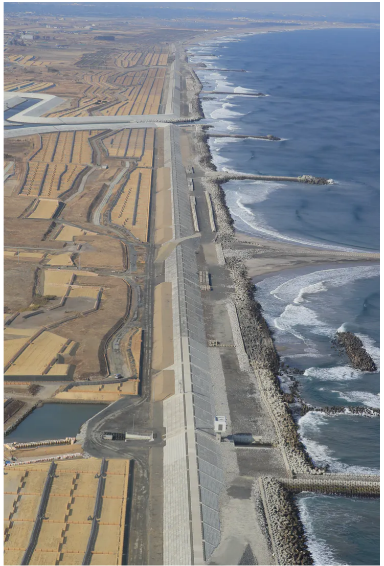
仙台湾南部海岸に建設された全長約30キロにおよぶ長大な堤防（宮城県山元町）
