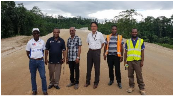
無償援助橋梁架け替え案件モニタリング
