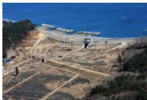
写真2－米田地区被災状況
