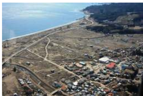
写真1－城内地区被災状況
