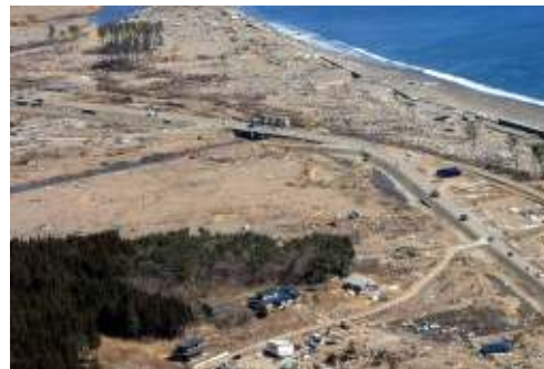
写真4－泉沢地区被災状況
