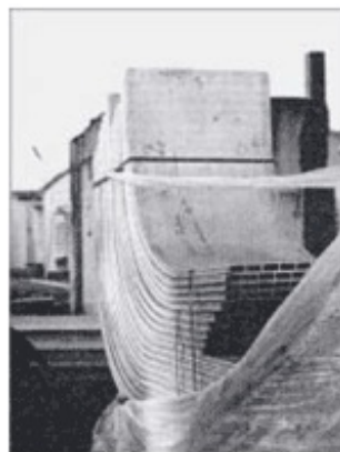
図-4.7 アルミ合金パネル曲面加工事例
