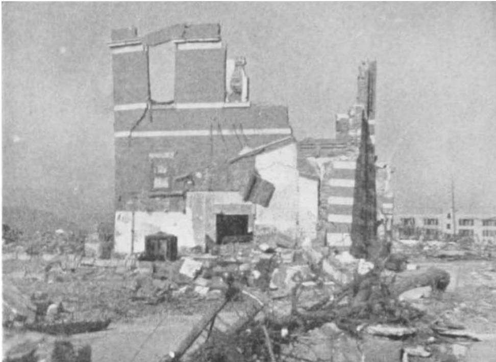
写真 15 広島。頑丈な構造で、英国の基準に匹敵する耐荷重レンガ壁を備えた 3 階建ての銀行ビル。このような建物へのこの程度の損傷は、爆心から半径 800m に及ぶ。遠景の鉄骨鉄筋コンクリート建築物の挙動と比較のこと。
