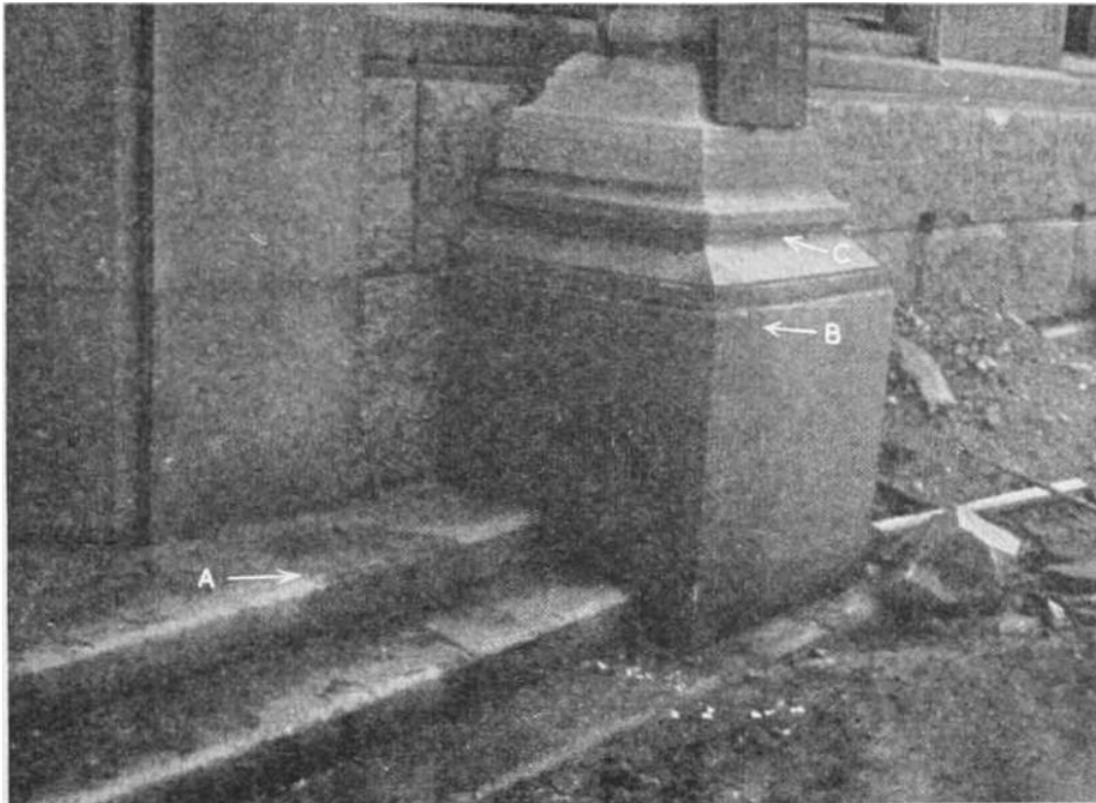
写真 21 広島。爆心から 200m の、閃光燃焼効果により研磨花崗岩の粗面化。(A) 階段に座った人物、(B) 階段に隣接する台座の隅によりかかる人物、(C) 台座の影によって遮蔽された部分のみの研磨面が残っている。
