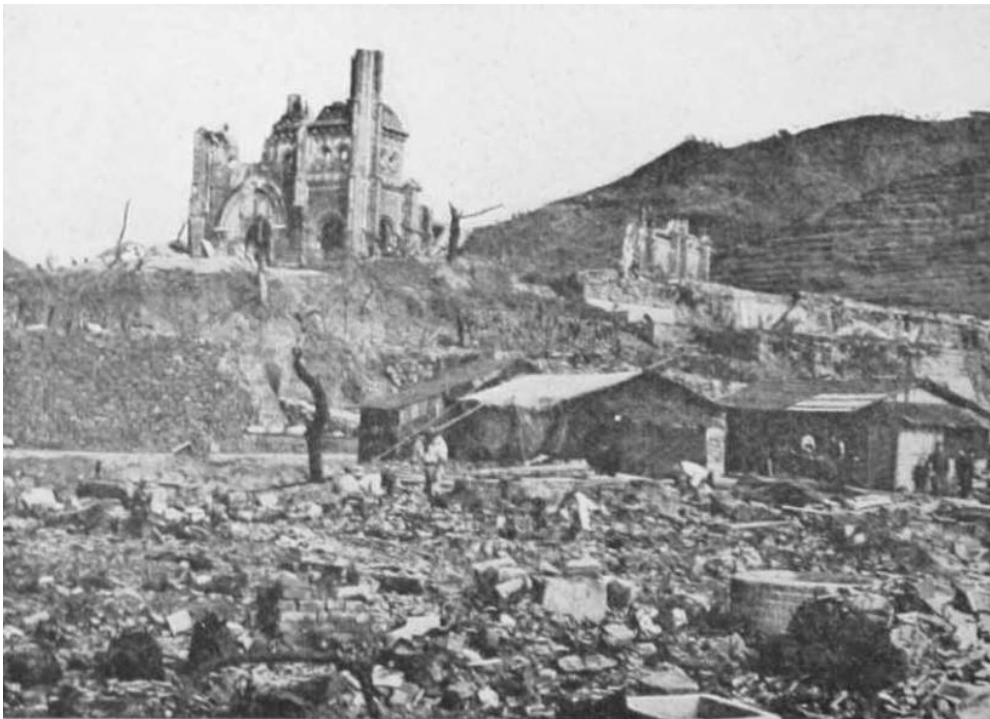
写真 16 長崎。爆心から 600m のローマカトリック大聖堂。壁は耐荷重性レンガ造。損傷の大半は爆風によるもの。火災はその後可燃性瓦礫を燃やし尽くした。前景は、原爆後に日本人が一時居住用に建てられた小屋。
