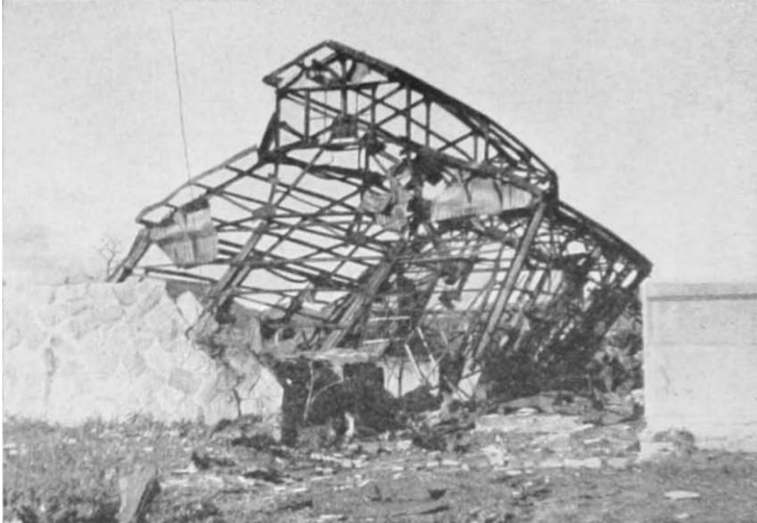
写真 11 広島。爆心から 400m の小さな鉄骨建築物は、鉄骨全体が折れ曲がり、爆発の反対側に建物は傾いている。
