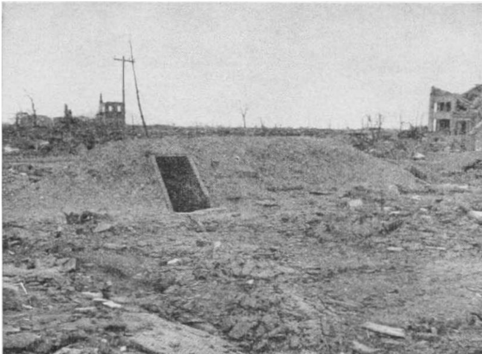
写真 17 広島。右の爆心から 300m の、典型的な部分的地下の土で覆われた木材骨組みのシェルター。完全地下シェルターと同様に、露出していない部分に爆風の被害は見られない。露出した木造部分は閃光燃焼しやすい。内部爆風が避難者を投げ飛ばし、ガンマ線で死傷した可能性がある。
