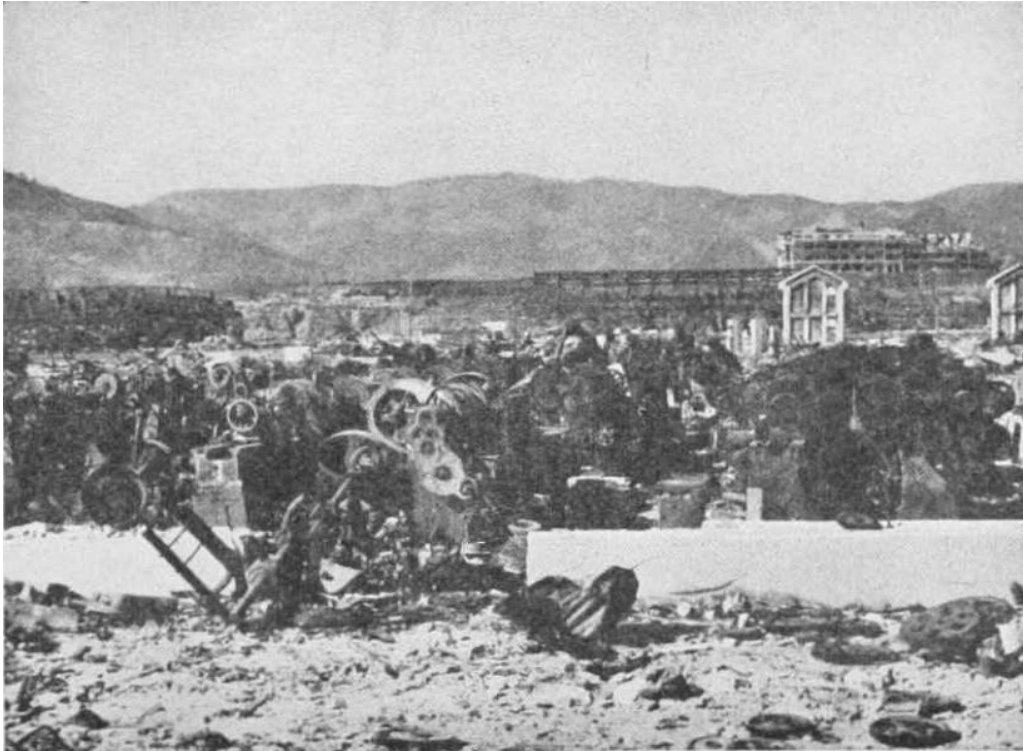
写真 13 長崎。爆心から 800m 地点。爆風と火災によって破壊された多くの木材工場の 1 つにある典型的な破損した機械。いくつかの機械は建物の動きによって覆された。一部は火災だけで破壊された。他は天候にさらされて損傷している。
