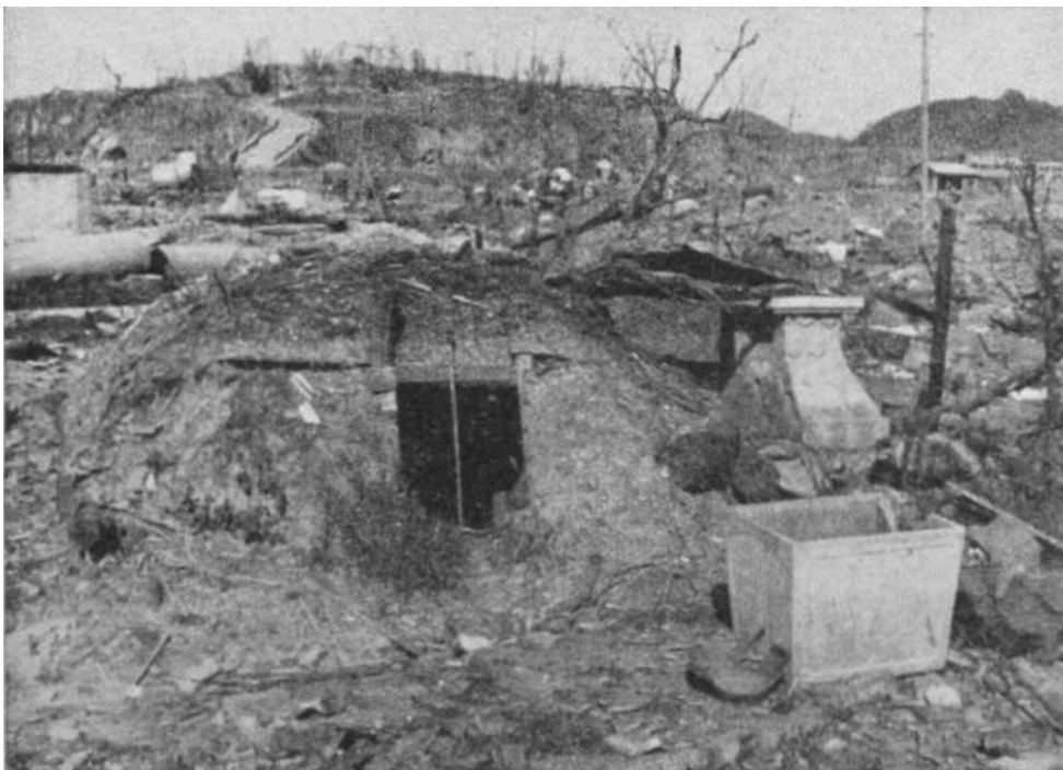
写真 18 長崎。右の爆心から 100m 以内にある、典型的な小型の土で覆われた木材骨組みの裏庭シェルター。このようなシェルターは多数あったが、300m 以内にあった、このシェルターに近い屋根のほぼすべてが損傷したが、爆心から 800m 以遠では、損傷はなかった。
