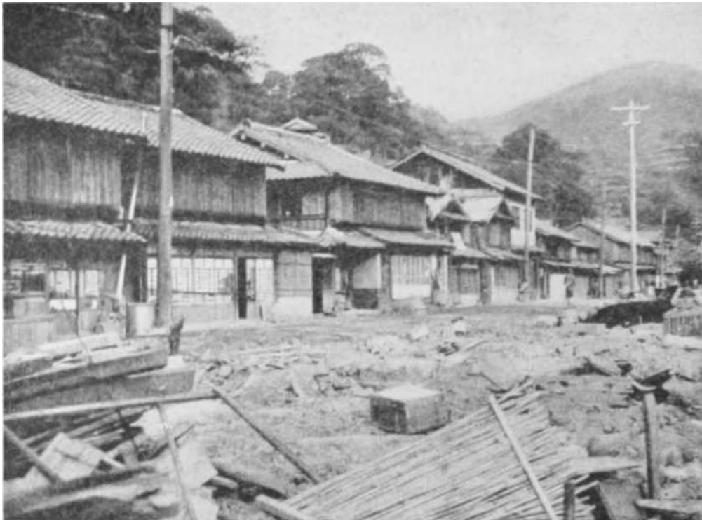
写真 19 長崎。周辺の丘により被害から遮蔽された通り沿いの典型的な日本家屋。同様の構造の建物が長崎と広島の建物の大部分を占めていた。
