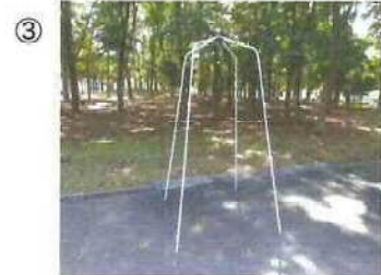
③ 骨組み完成
